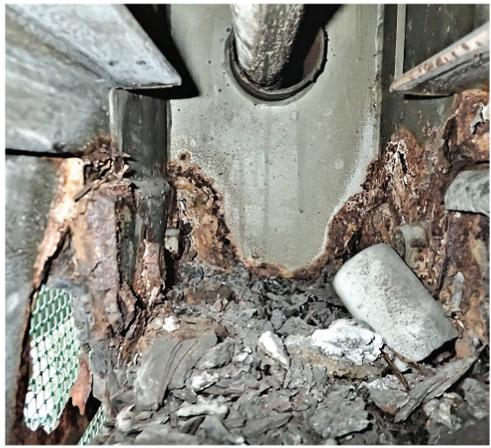
高欄内部の断面欠損など
