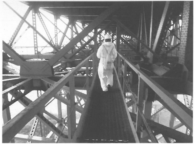
写真-6 橋梁内部
