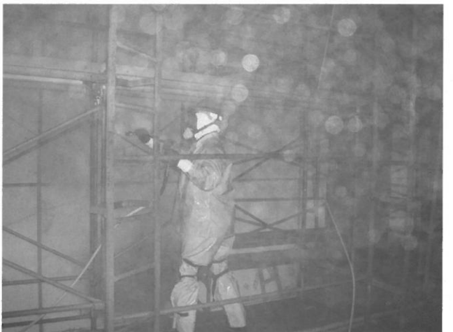
写真-10 プライマー塗装後の水洗い作業
