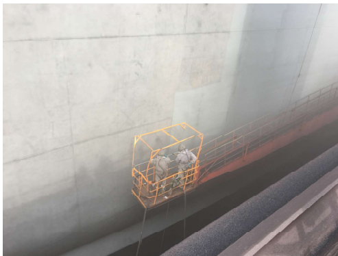
写真19 ブラスト施工中1
