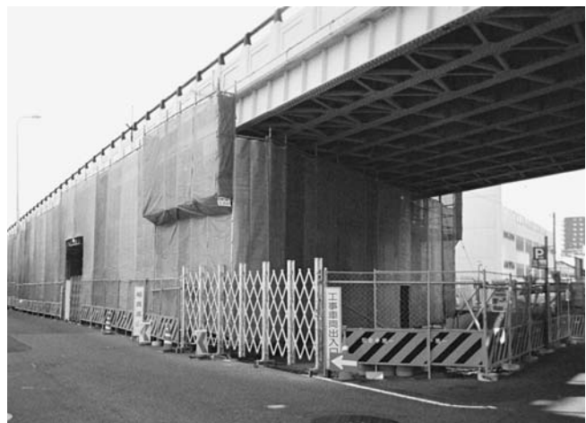
足場架設が終わった北方貨物線高架橋
