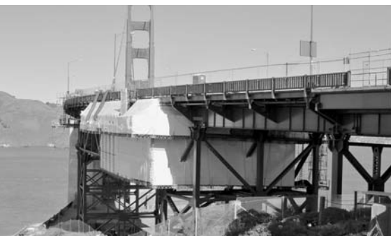
常設足場とシュリンクラップ
