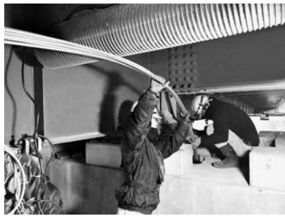
補強作業の様子(写真と下図は三井住友建設提供)
