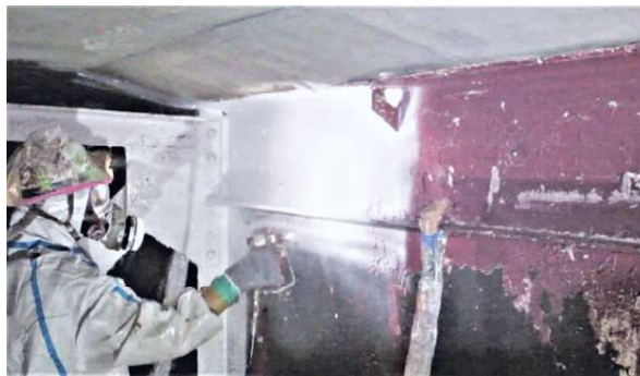
ネオハクリ工法NE-1の吹付け作業(ネオス提供)
